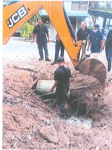
ปรับปรุงท่อระบายน้ำ
