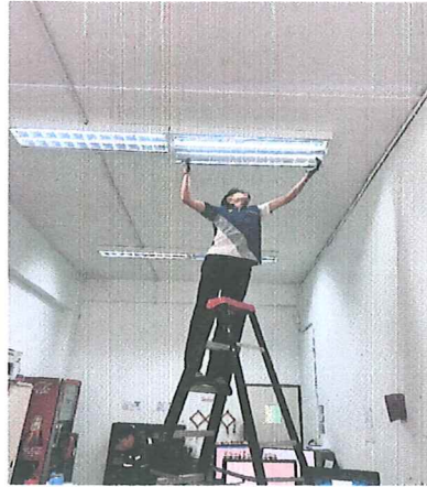
ปรับปรุงระบบไฟฟ้า
